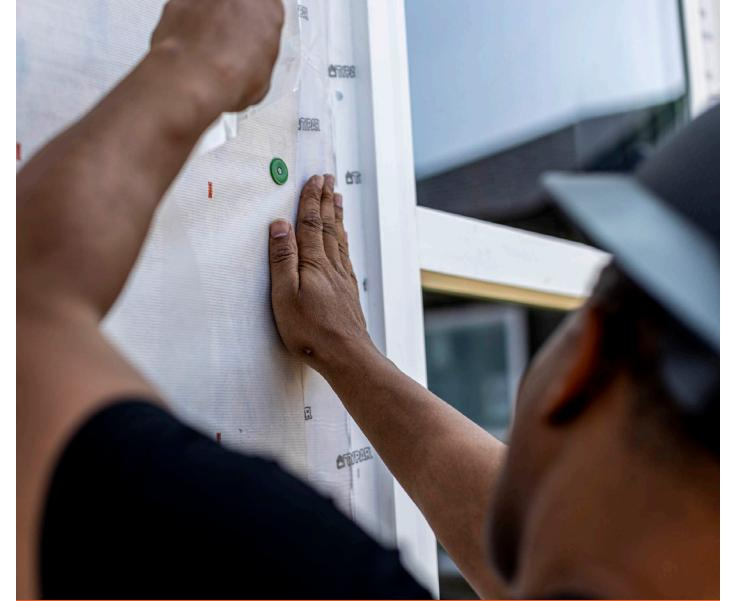
**LE SOLIN EN ACRYLIQUE TRANSPARENT TYPAR RÉPOND À UN DÉFI RÉCURRENT, SOIT ASSURER LA VISIBILITÉ DES MOTIFS DE FIXATION AUTOROUND DES FENÊTRES ET DES PORTES PENDANT L'INSTALLATION ET L'INSPECTION.**
