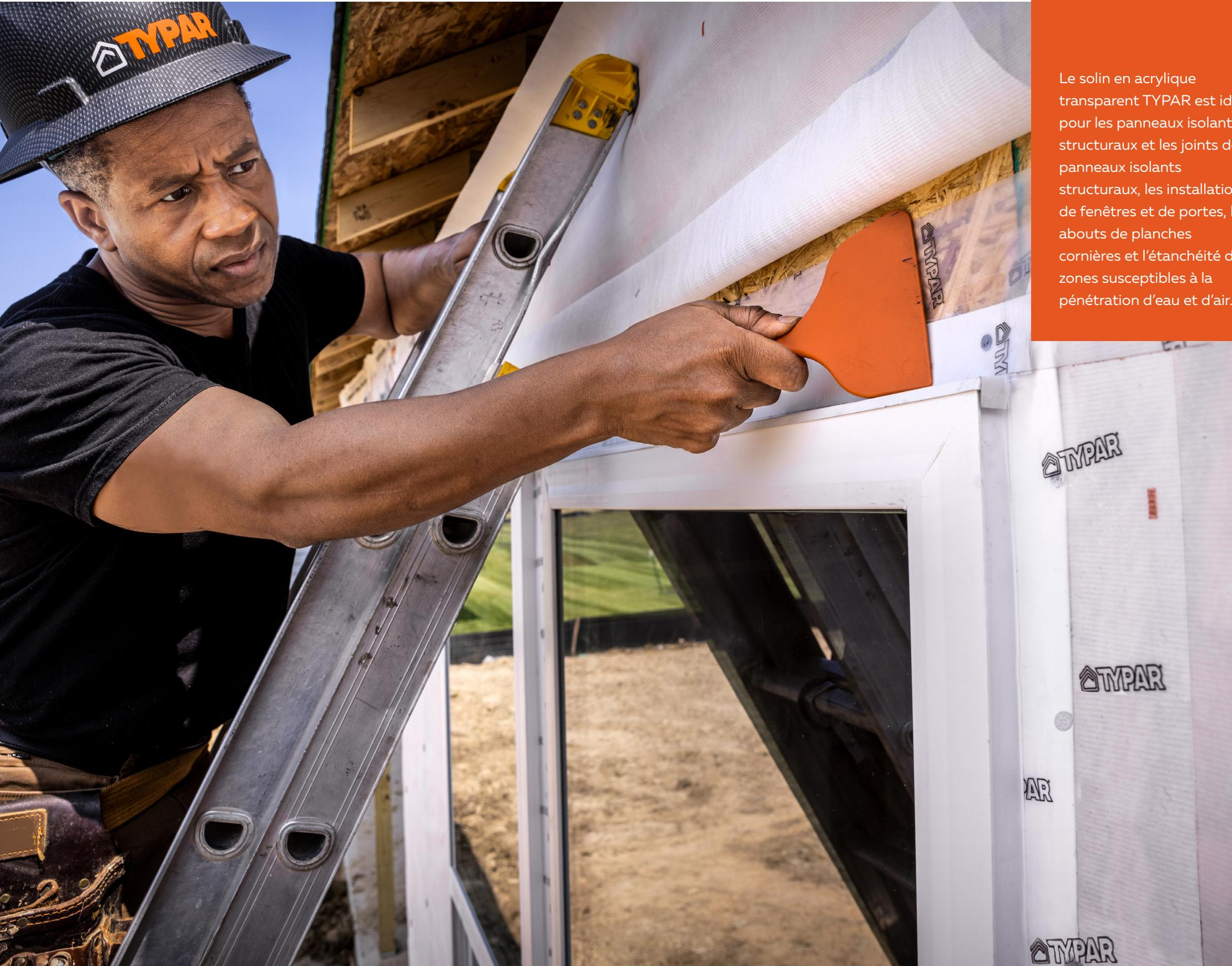
Le solin en acrylique transparent TYPAR est idéal pour les panneaux isolants structuraux et les joints de panneaux isolants structuraux, les installations de fenêtres et de portes, les abords de planches cornières et l'étanchéité des zones susceptibles à la pénétration d'eau et d'air.
